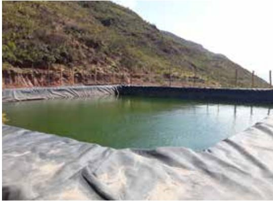
Reservorio impermeabilizado con geomembrana.
